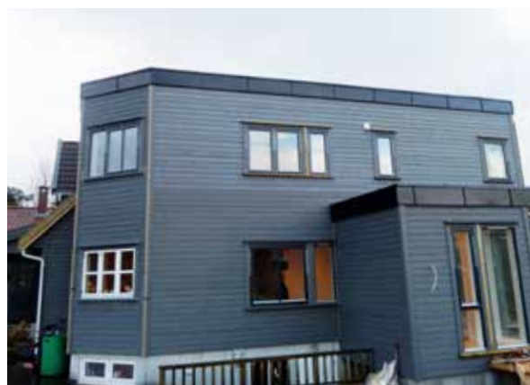
Uten tvil det mest spennende tilbygget i 2015, Stort tilbygg for en trivelig familie i vågsbygd.
