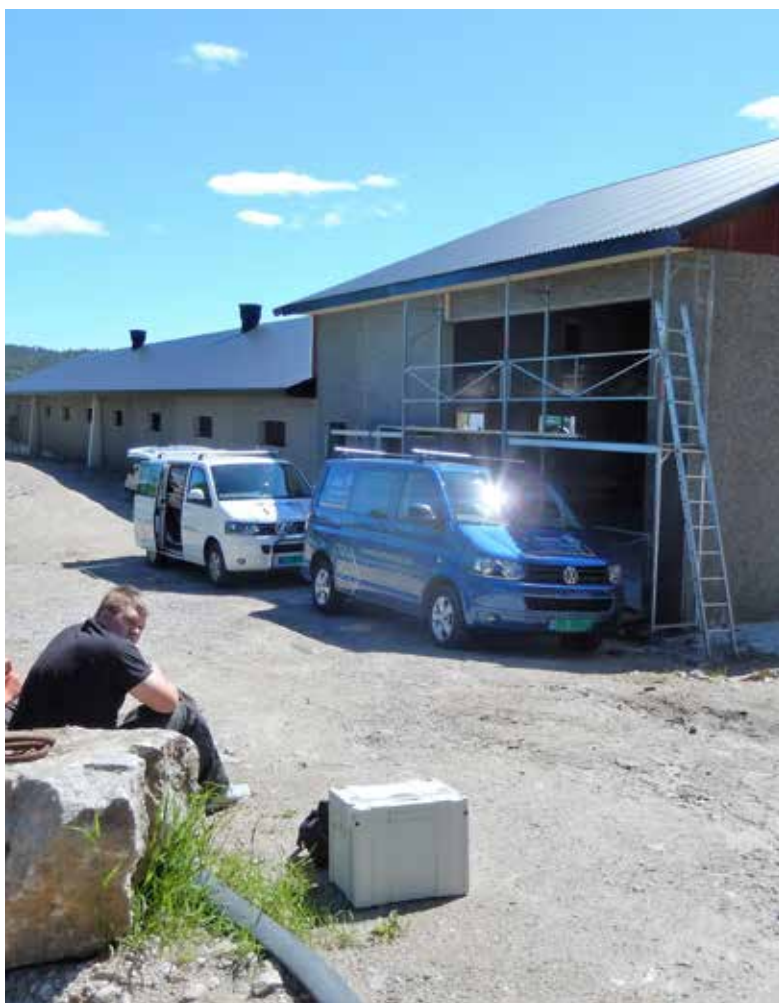
Her er vi nesten i mål med trearbeidet på et oksefjøs vi bygger for bygdas storbonde, fjøset rommer plass til 250 dyr.
